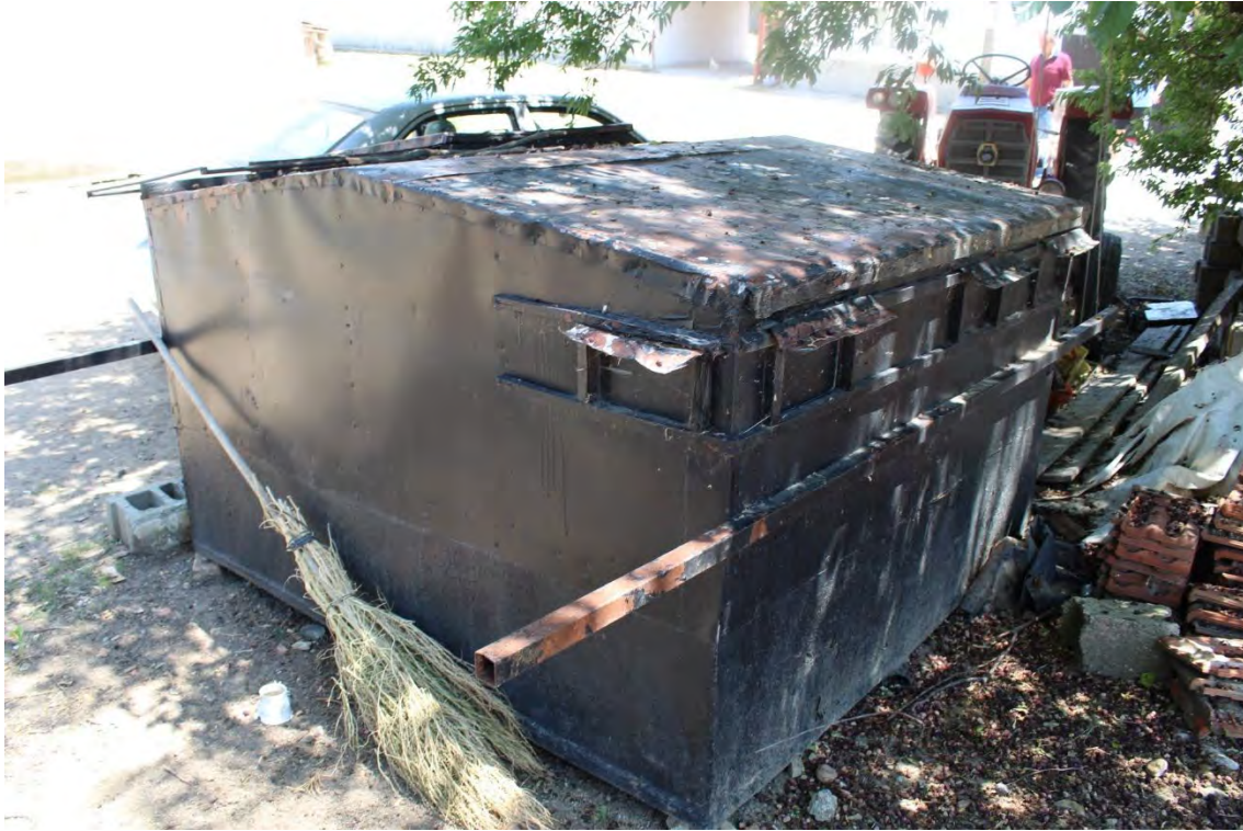
Fot. 6 Budka strzelnicza bez kamuflażu. Posiada trzy otwory strzelnicze z przodu, jeden na każdym boku i jeden z tyłu. Właz znajduje się na dachu, po drugiej stronie budowli. Fot. Mikołaj Zaradzki.
